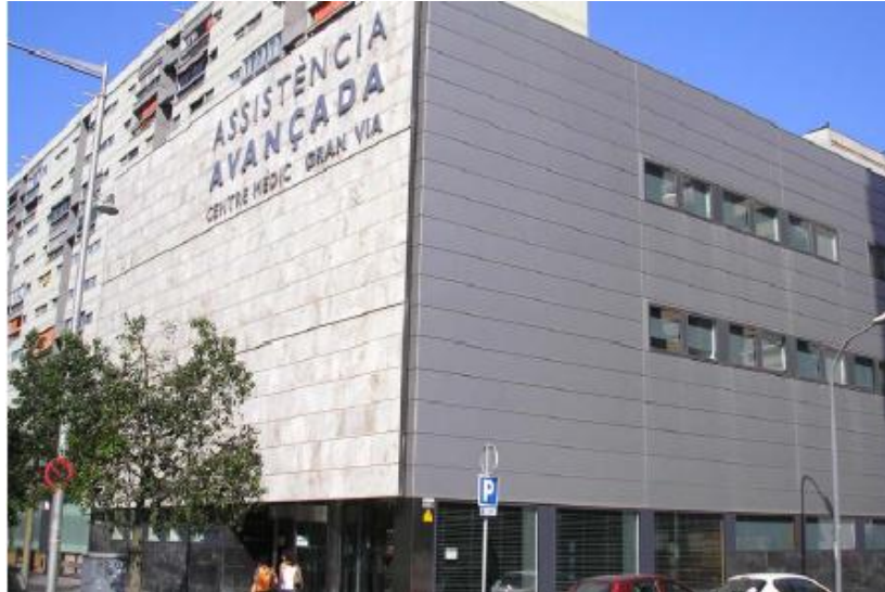
EDIFICIO GRAN VIA CORTS CATALANES, 142
